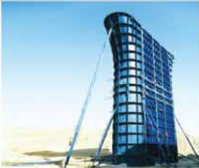
Çandabil Köprüsü / Türkmenistan
